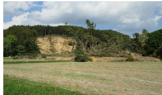
図-1 北海道胆振東部地震 被災状況 1) (厚真町)
