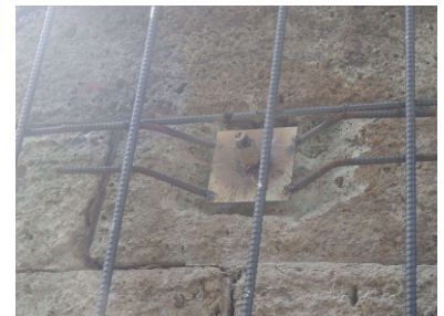
写真3 補強材頭部
