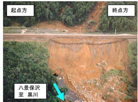
(崩壊後の状況：事例2)
