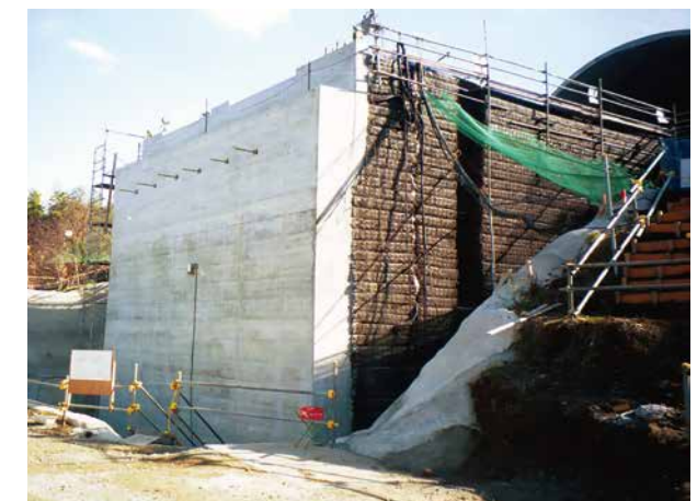
RRR-A 工法実績例（施工時）
