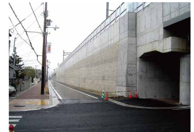
仮土留めを併用した急勾配化 (完成)
