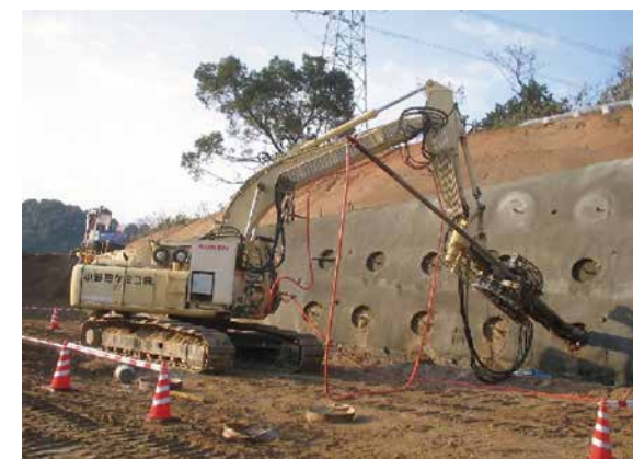
切土補強土擁壁 (施工中)
