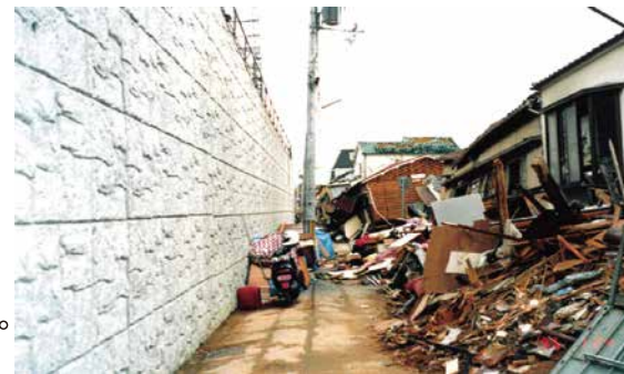
兵庫県南部地震での被害状況 (RRR-B 工法：無被害)
