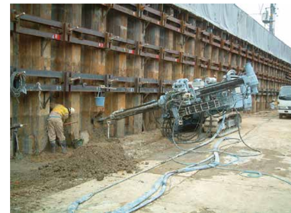
仮土留めを併用した急勾配化 (施工中)
