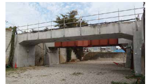
補強盛土一体橋梁（GRS 一体橋梁） * 公益財団法人鉄道総合技術研究所にて実施
