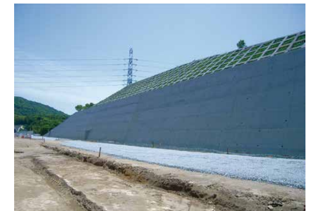
切土補強土擁壁 (完成)
