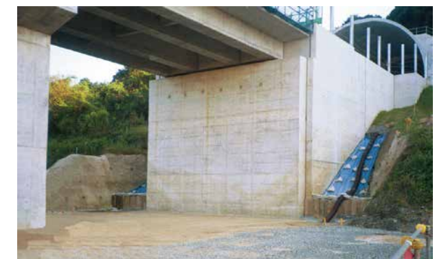
RRR-A 工法実績例（完成時）
