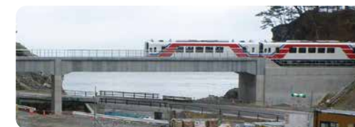
GRS一体橋梁実績例
