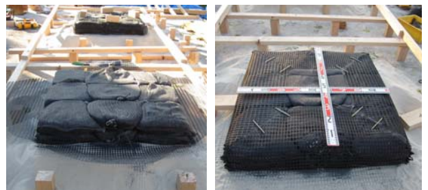
写真2 ジオテキスタイル土のう製作状況(左:製作段階,右:製作後)
