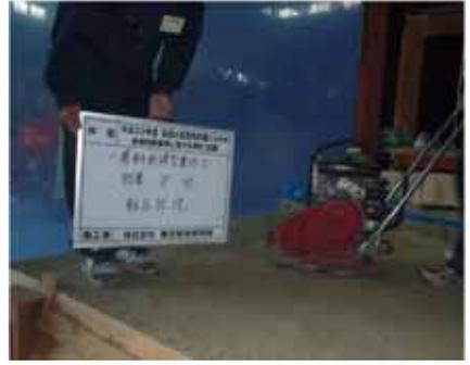
写真3 模型地盤の締固め
