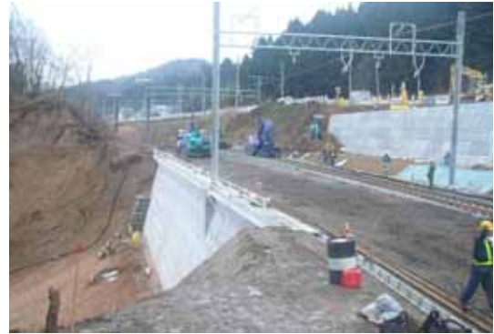
写真-4 上越線 221km000m 付近復旧状況
