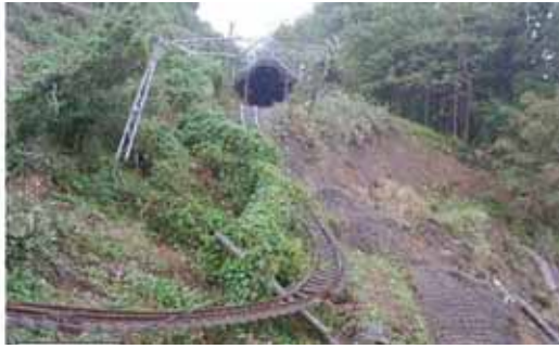
(a)崩壊状況 1
