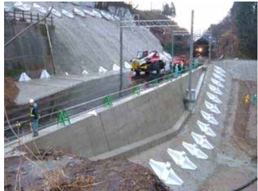
写真-2 上越線 220km300m 付近復旧状況
