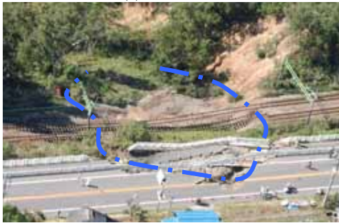
(b)崩壊状況 2
