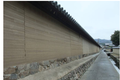
写真-1 法隆寺西院大垣東面
